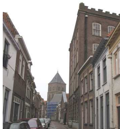
Foto : Annie van 't Zand Schoolgebouw als beeldbepalend pand in een monumentale omgeving
